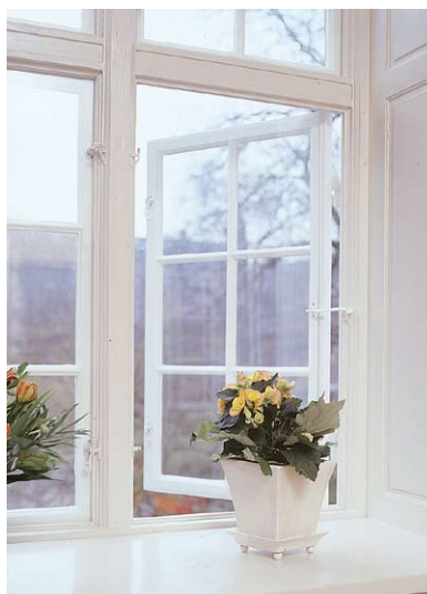
Vinduet åbnes uden rydning af vindueskarm.
